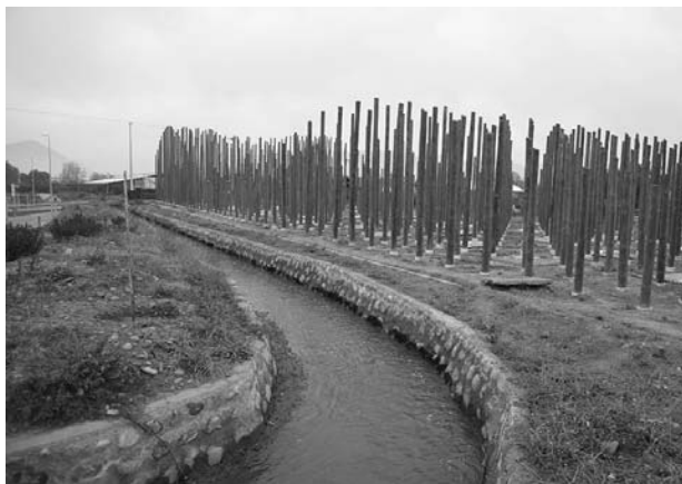
Imagen 3: Memorial de Paine en etapa de construcción.
