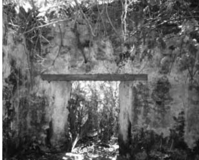
Figura 2: Fachada sur interna de las ruinas de San Pedro Fuente: Corpozulia, 2004
