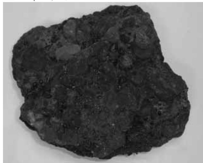
Figura 7: Muestra tomada del muro de calicanto Fuente: Corpozulia, 2004
