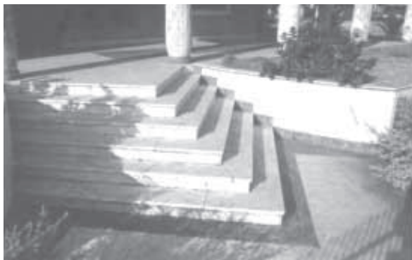
Figura 12: Detalle de escalinata en ángulo sobre el acceso exterior
