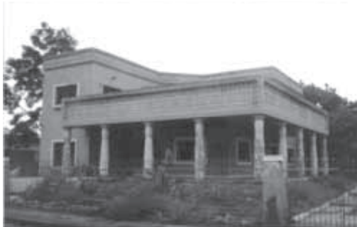
Figura 2 : Aspecto externo de la edificación Fuente: Sección de Patrimonio y Turismo, IFAD/FADLUZ, 1996
