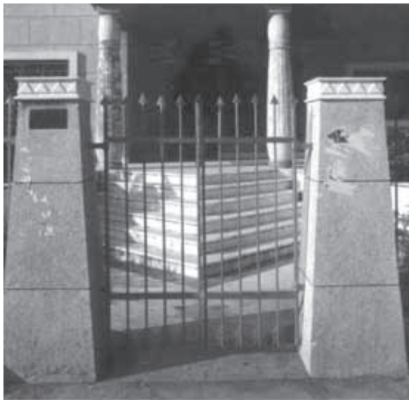
Figura 10 Pilonen en cerca exterior de la quinta
