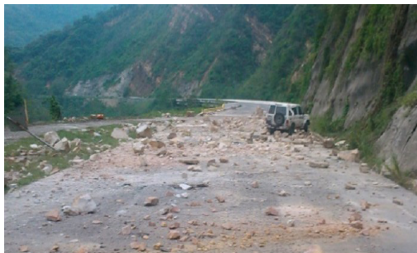
Figura 5. Derrumbes ocurridos durante tormenta sísmica posterior al estudio realizado en el sector, obsérvese el vehículo impactado.
