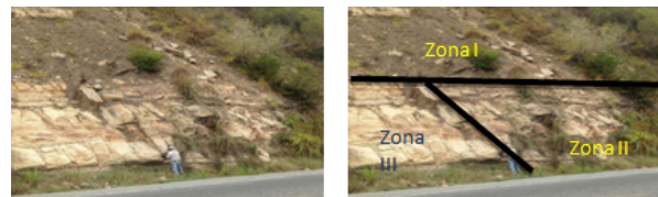
Figura 3. Zonificación y mediciones para el macizo rocoso del talud 3
