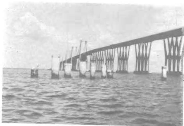
Figura No. 27 Pilotes de prueba situados al Norte del Puente.
