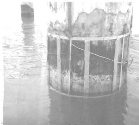
Foto No. 5.- Se muestra la forma final de colocación del brazalete. Obsérvese los cables utilizados para la conexión de la estructura con el ánodo sumergido (Protección de la zona sumergida y la soldadura del brazalete con pletina del ánodo sumergido para conexión del primero con la estructura).
