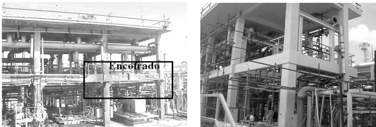
Figura 7. (a) Marco en reparación. (b) Marco reparado.
